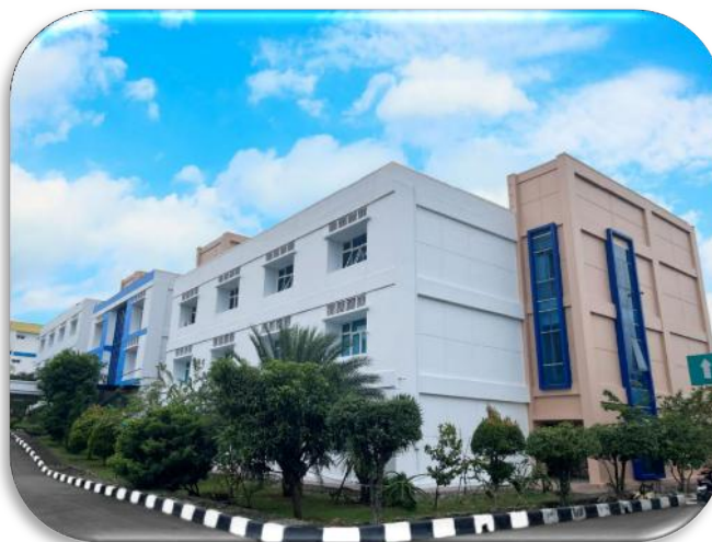
Gambar 4 Gedung Arjuna Pusat Pemberdayaan Bahasa dan Sastra
